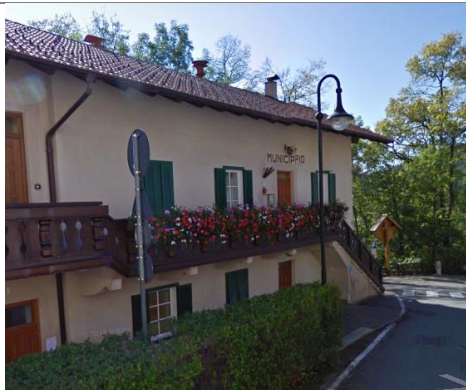
Ruffrè-Mendola – edificio Comunale
